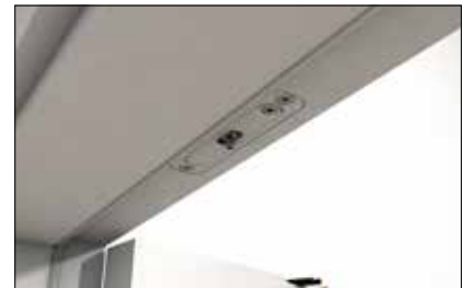
Auslöser – in Holzzarge eingelassen.
